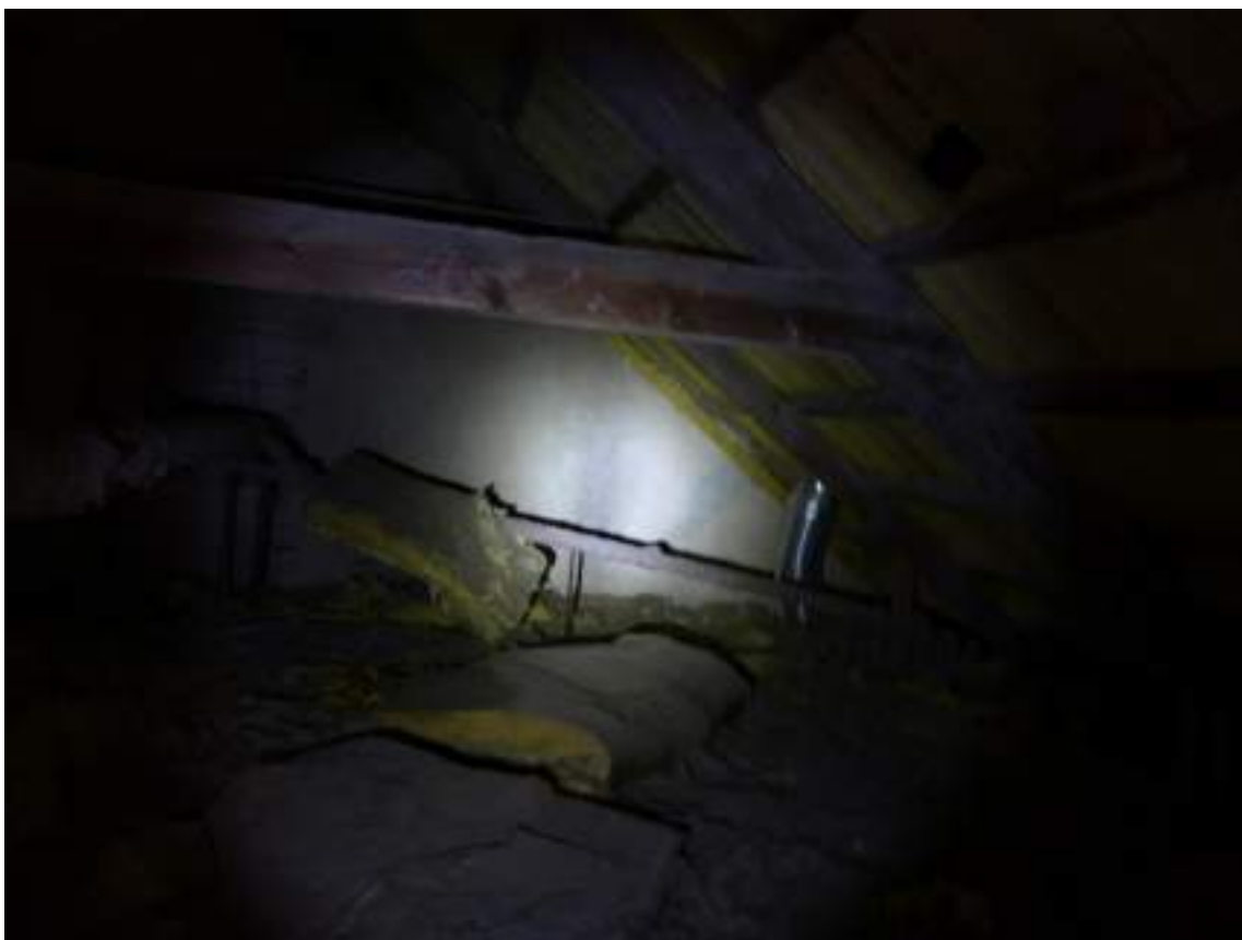
Figure 11: vue de l'intérieur du comble côté mairie, accessible aux hirondelles
