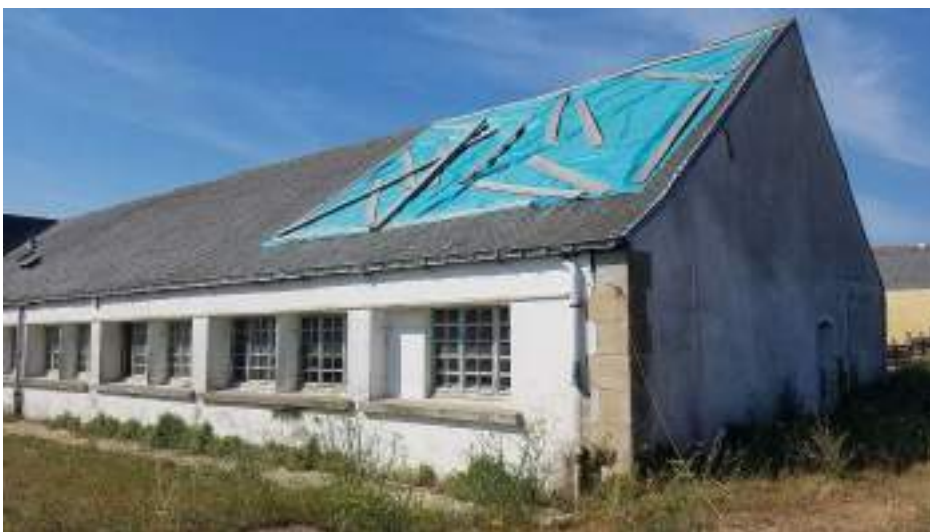
Toiture éventrée protégée par une bâche et traces d'infiltration d'eau sur les plafonds intérieurs
