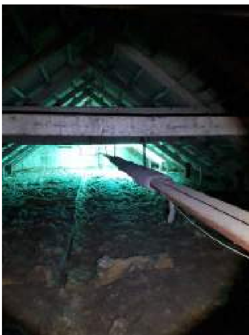
Puits de lumière dans le comble (toiture éventrée) et vieux guano de chauves-souris au sol
