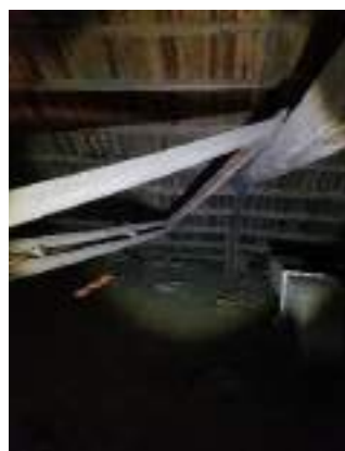
Photo 3: Comble concerné par les travaux
