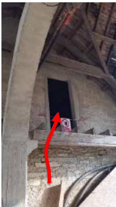
Photo 7: Ouverture permettant l'accès aux combles
