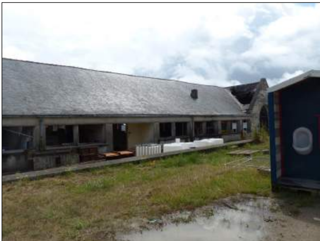
Photo 1 : vue de la longère projet – côté terre
